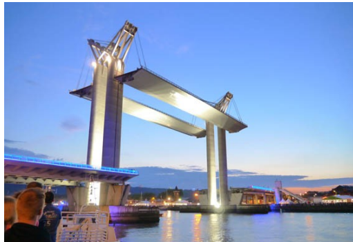
Le 6ème pont de Rouen, dernier pont maritime
