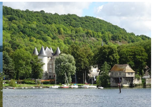
Site des tourelles à Vernon
