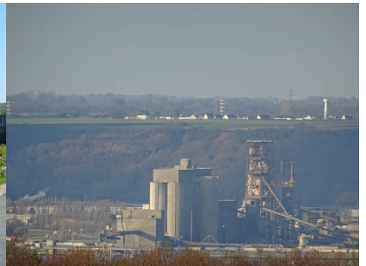
Le site industriel rive nord de la Seine
